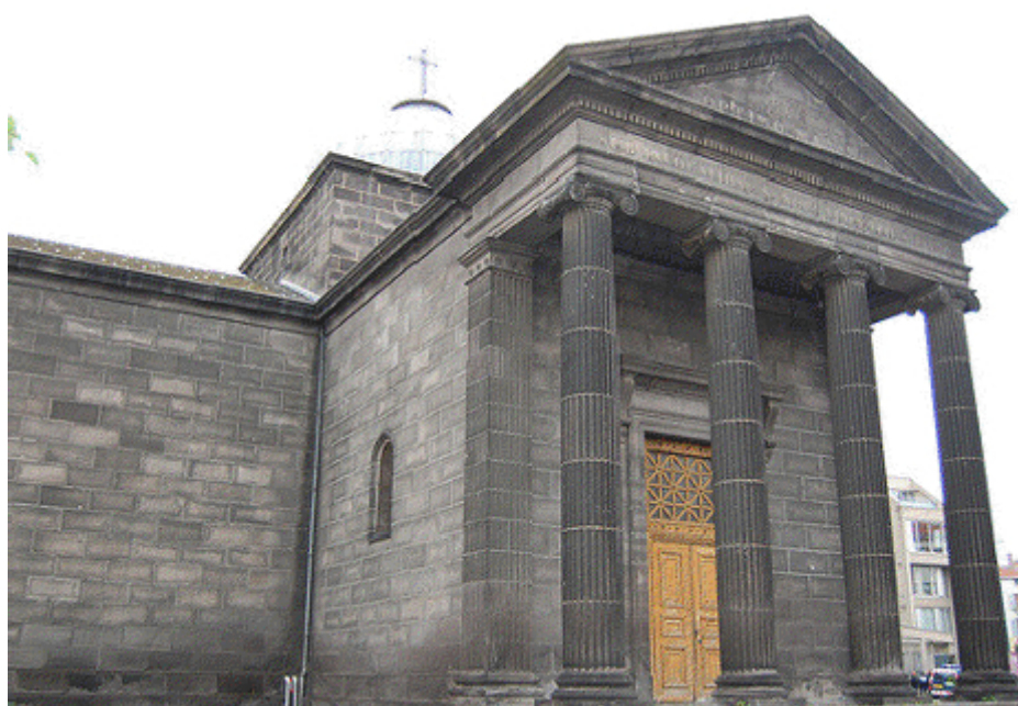
Chapelle de l'hôpital général de Clermont-Ferrand
